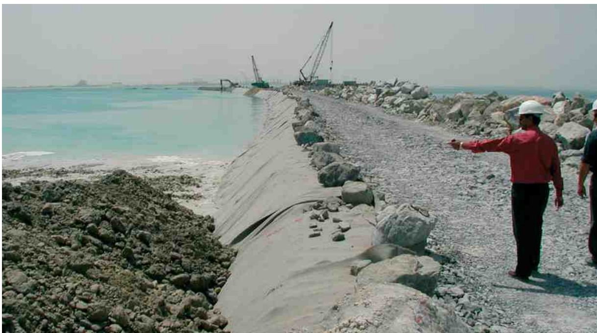
Zdroj: Palm Island, Dubai. Instalace Fibertexu F-650M. Geotextilie Fibertex bude kompletně zasypána štěrkem a pískem.
