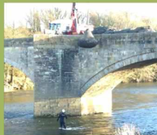
Velká Británie 2010 ochrana základů pilířů mostu
